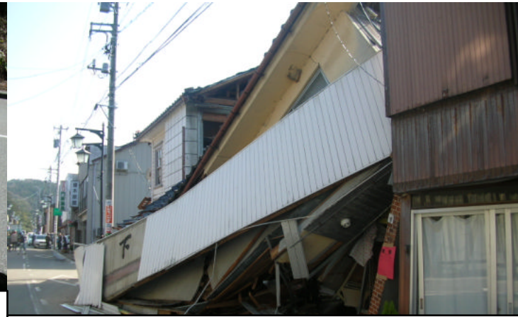
3/27門前総合支所付近。開口部の大きい商店が大きな被害を受けている。
