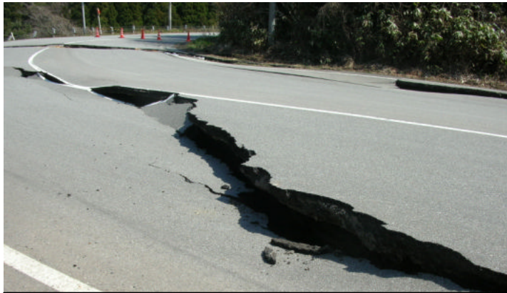
3/26地震翌日の午前の時点で、門前地区を除き、橋と道路の接合部の段差や走行に支障のする小規模な亀裂は、すでに補修済みか補修作業中だった。
