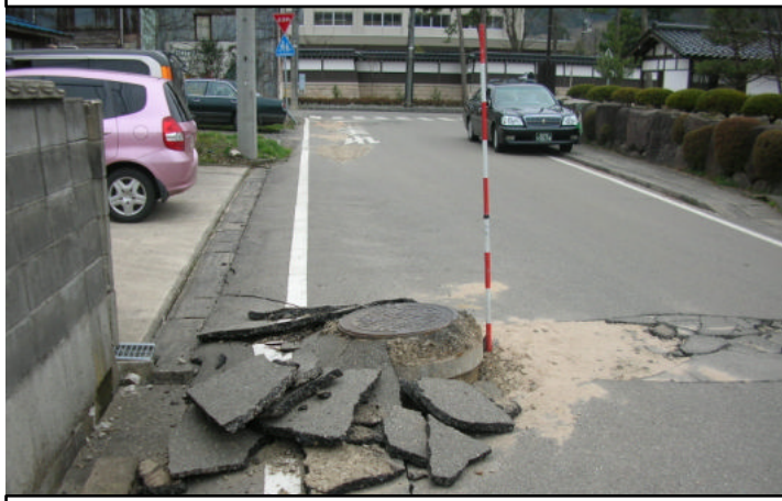
3/27門前東小の横の道。液状化で下水道のマンホールが浮き上がっている様子。100箇所程度発生。
