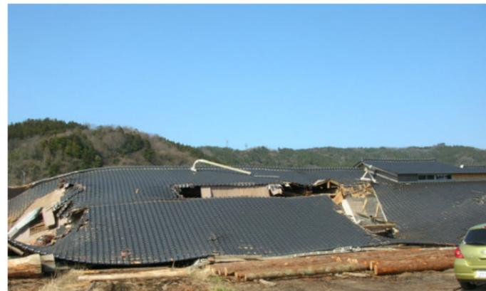
3/26輪島市門前町道下(とうげ)地区。大きな製材所の屋根がすべて落ちている。
